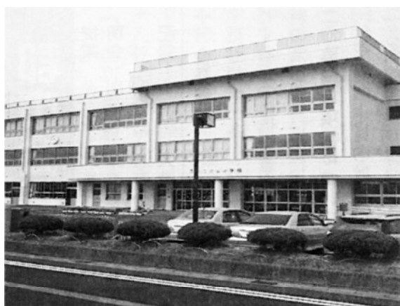
完成した新校舎
